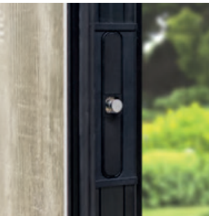
Dreidimensional verstellbares Schließteil im Türflügel
