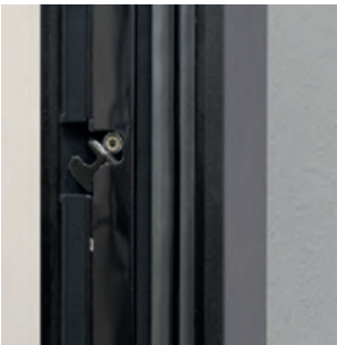
Der Verschluss mit pferdekopfförmiger Verriegelung im Rahmen
